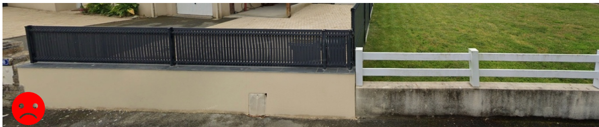
Problème d'harmonie entre clôtures voisines
